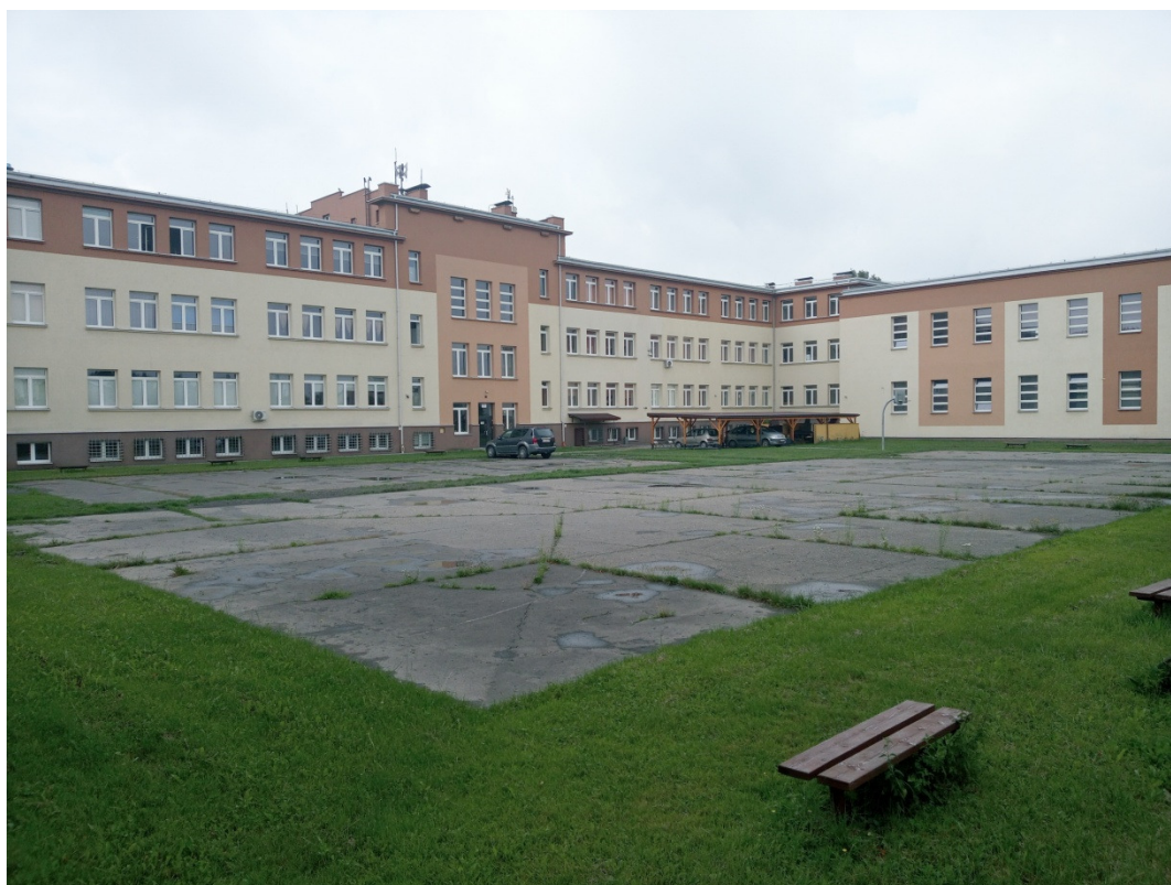
Zdj. nr 3 - Teren planowanej inwestycji. Strona wschodnia ZSO nr1 w Tarnowie. Istniejące zniszczone nawierzchnie boisk.
