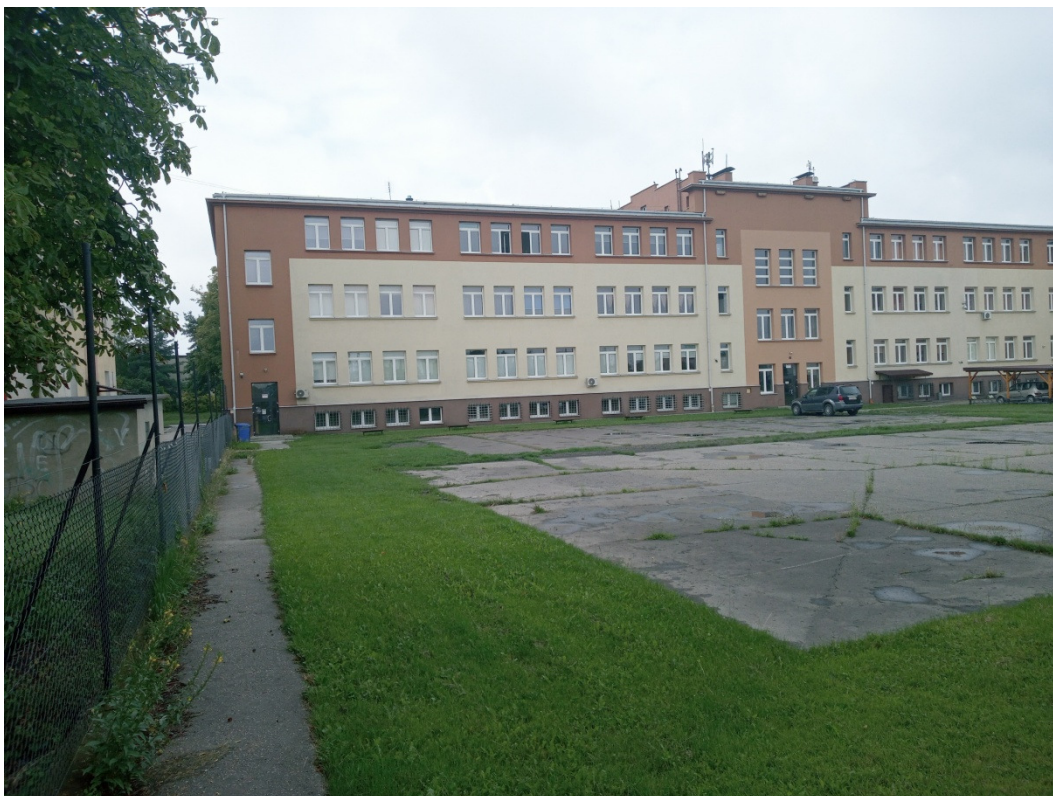
Zdj. nr 1 - Teren planowanej inwestycji. Strona wschodnia ZSO nr1 w Tarnowie.
