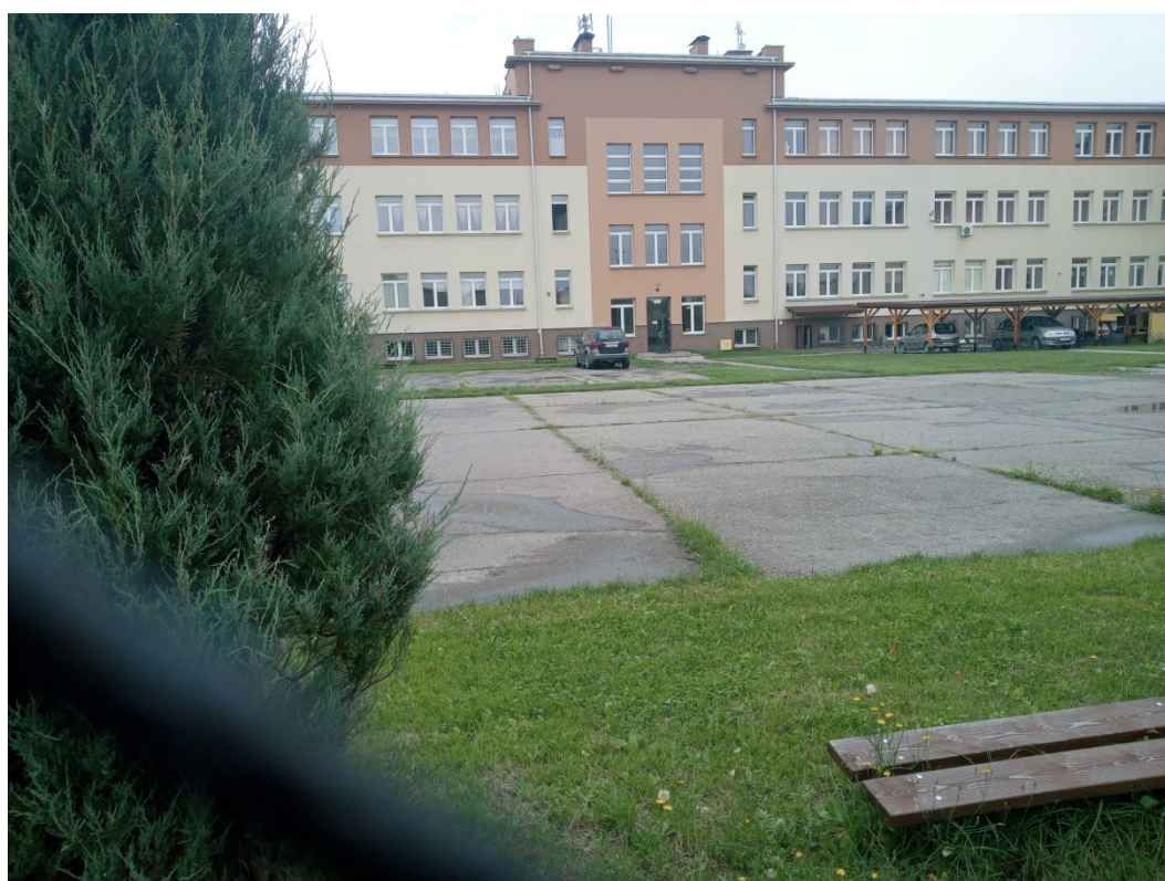
Zdj. nr 2 - Teren planowanej inwestycji. Strona wschodnia ZSO nr1 w Tarnowie.
