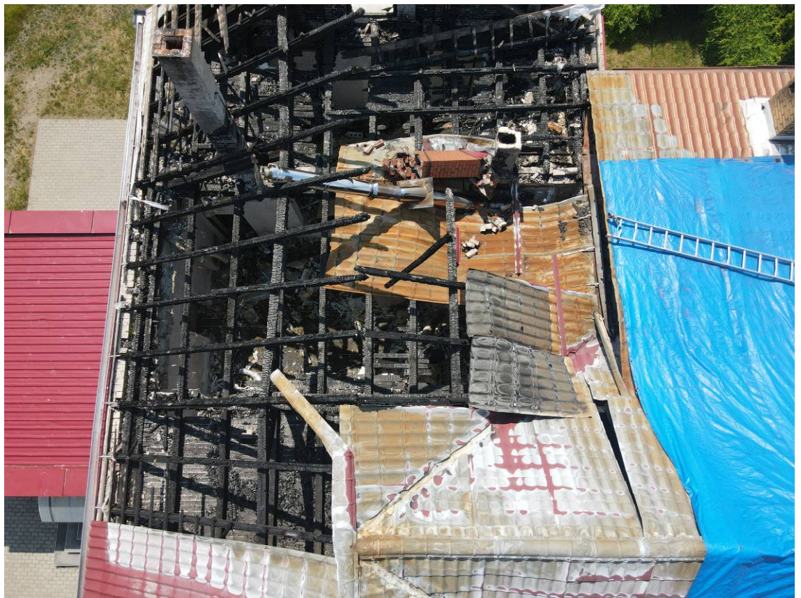
Fot. Nr 7. Widok budynku – zniszczenia spowodowane pożarem i akcją gaśniczą
