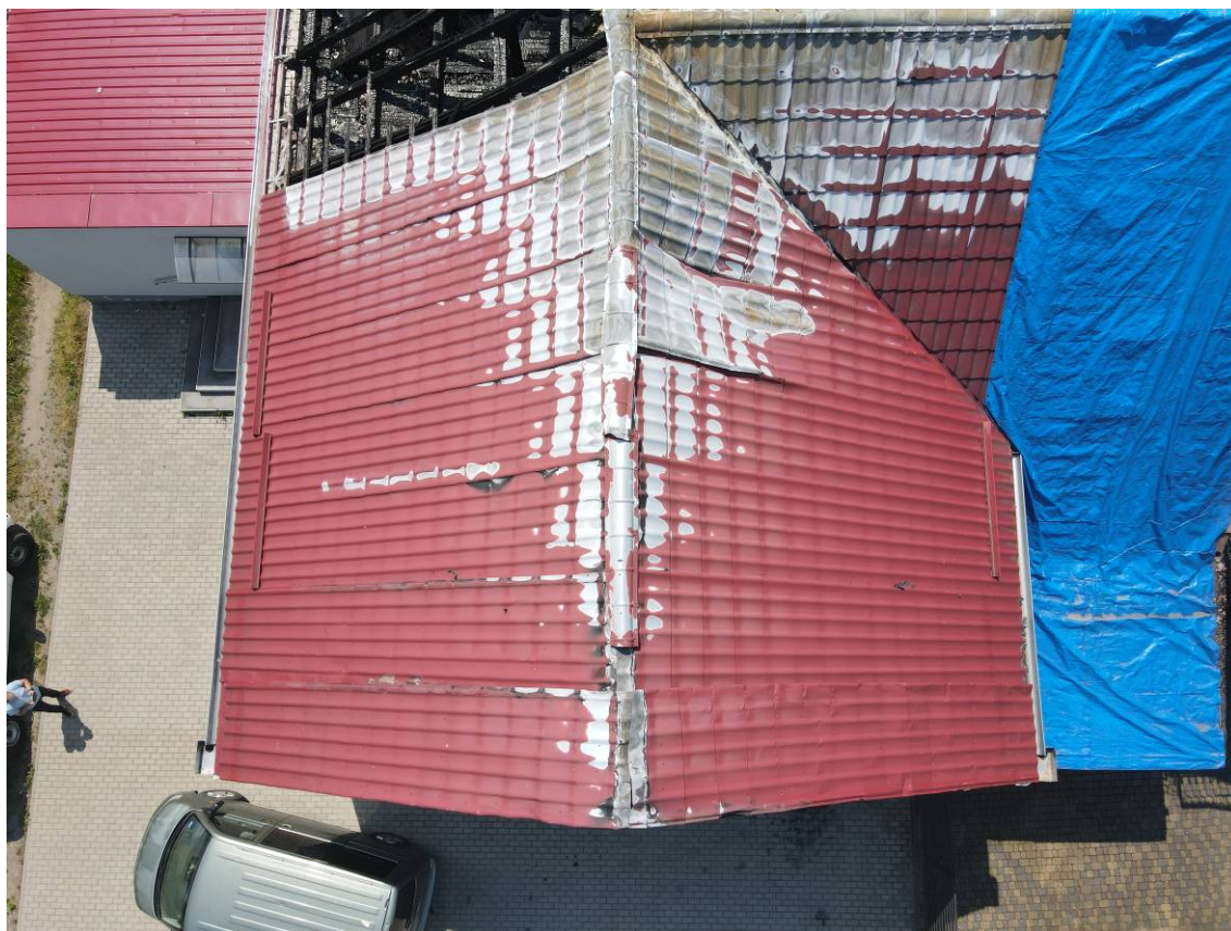
Fot. Nr 9. Widok budynku – zniszczenia spowodowane pożarem i akcją gaśniczą
