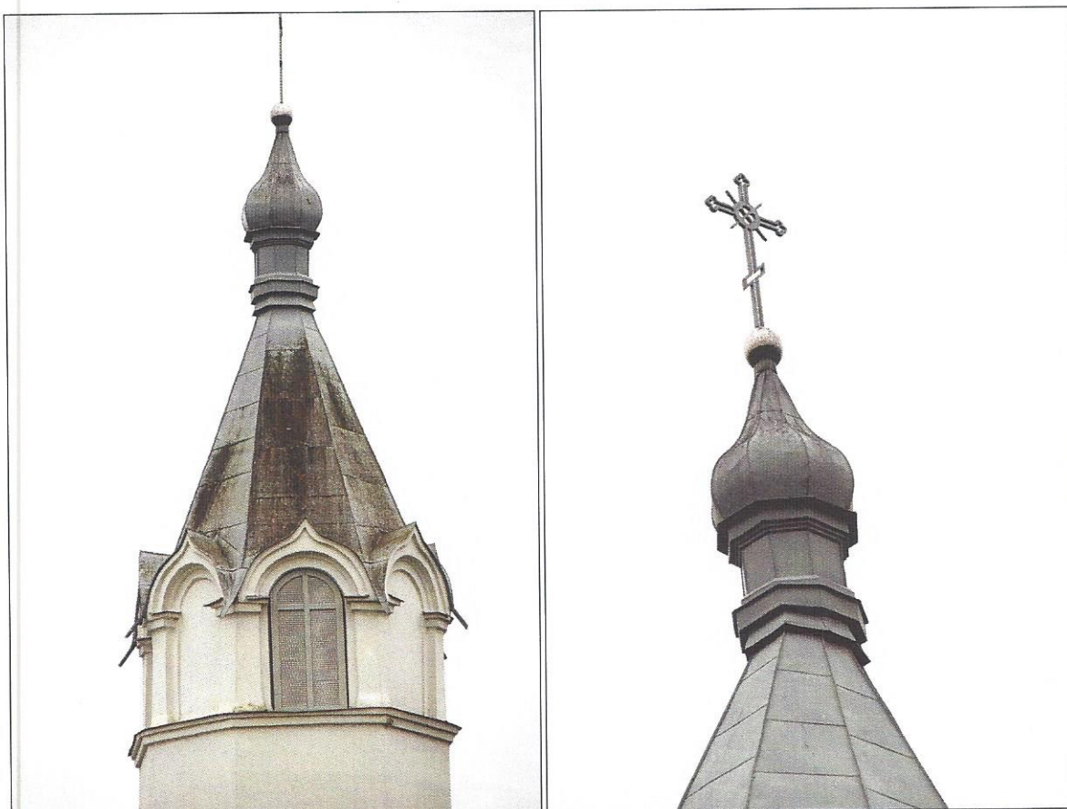
Kopuła na wieży lekko skrzywiona
