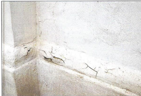
Wyraźnie spękanie tynki
