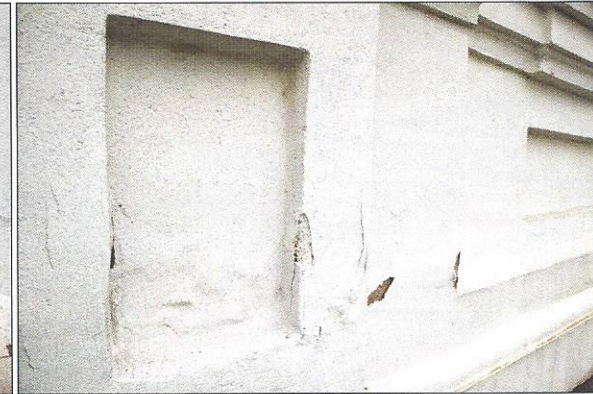
Wyraźnie spękanie tynki
