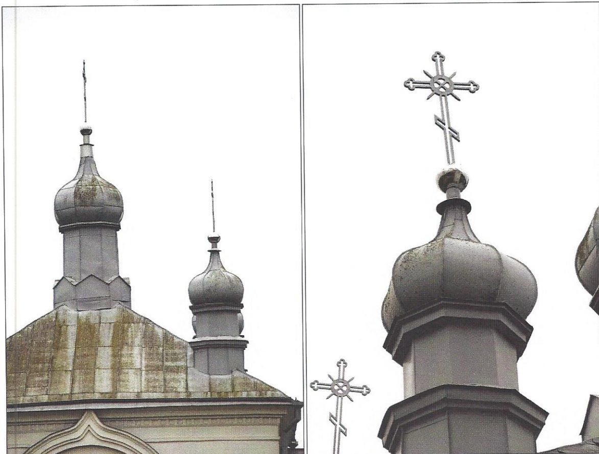
Widok dachu i nieforemnych oraz lekko poprzeczylanych kopuł nad nawą główną
