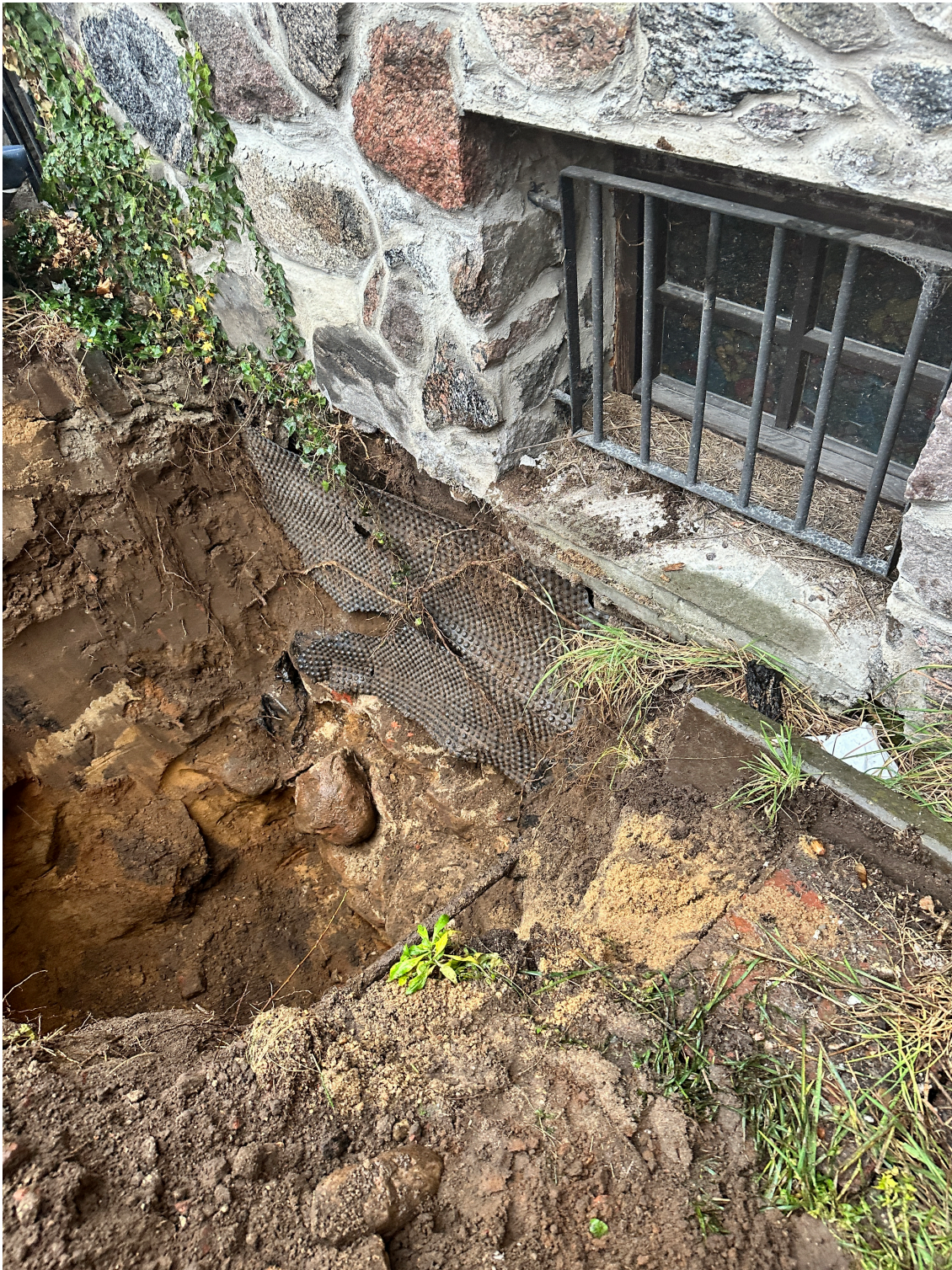
Fot. 16 Obiekt przed konserwacją odkrywką fragmentu fundamentu.
