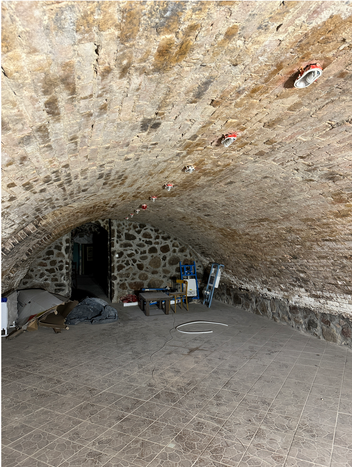
Fot. 18 Obiekt przed konserwacją widok ogólny fragmentu piwnic.
